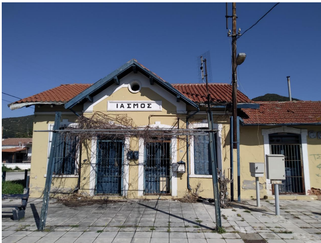
Εικόνα 4.14: Ίασμος-Κτίριο Σιδηροδρομικού Σταθμού (πηγή: ίδια λήψη)
