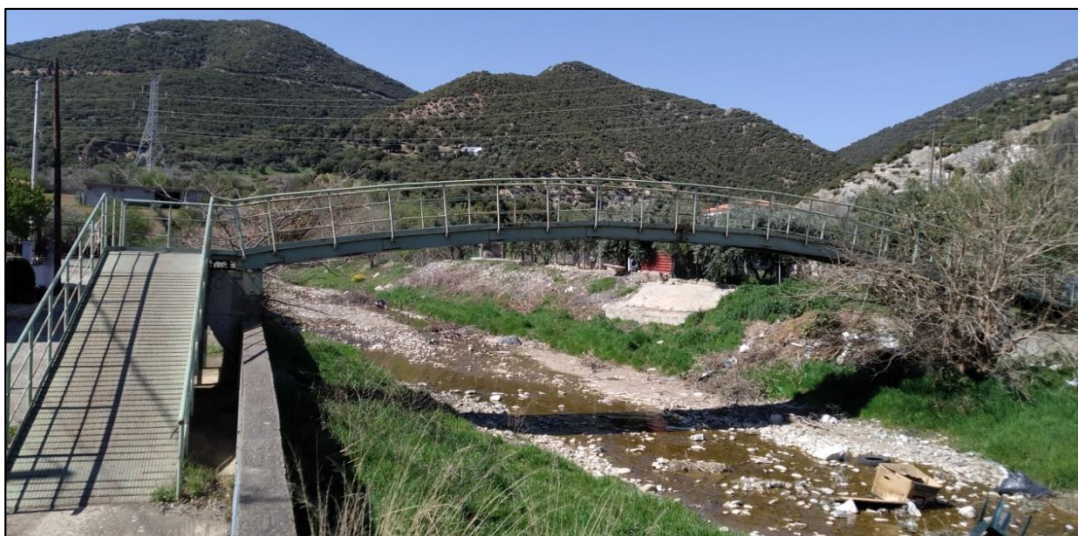
Εικόνα Α4.33: Αντιπλημμυρική προστασία στον οικισμό Κοπτερού (πηγή: Ίδια λήψη)
