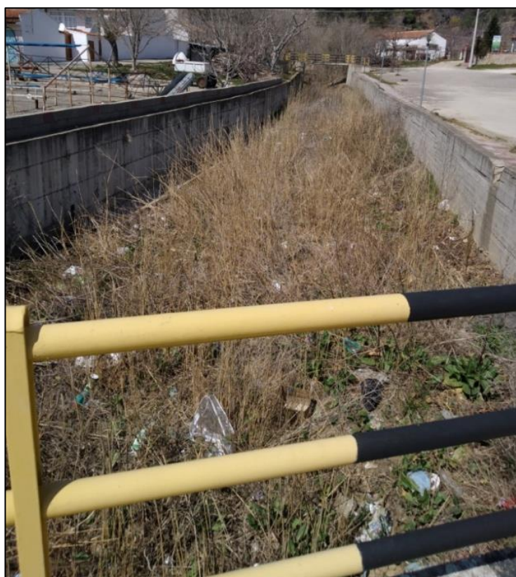
Εικόνα Α4.35: Αντιπλημμυρική προστασία στον οικισμό Θάμνων (πηγή: ίδια λήψη)
