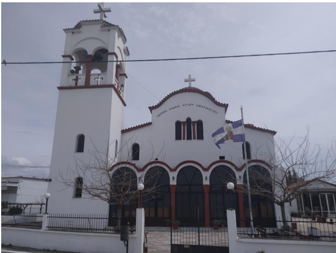
Εικόνα 4.8. Πρόσοψη Ιερού Ναού Αγίου Αθανασίου (Πηγή: Ίδια λήψη)
