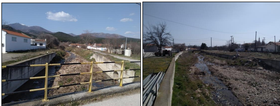
Εικόνα Α4.26: Αντιπλημμυρική προστασία στον οικισμό Ασωμάτων (πηγή: ίδια λήψη)
