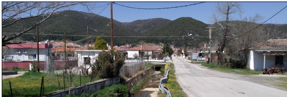
Εικόνα Α4.28: Αντιπλημμυρική προστασία στον οικισμό Ιάσμου (πηγή: Ίδια λήψη)
